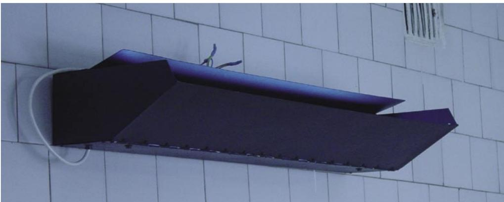
*Una lampara de luz ultravioleta con dispositivos de proteccion*
